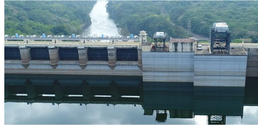
Upstream face geomembrane (Servalar dam, TANGEDCO).
