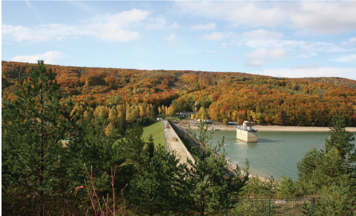
Figure 9 : Veľká Domaša dam
